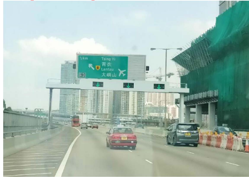
Existing Directional Sign 現時的路線指示標誌:
