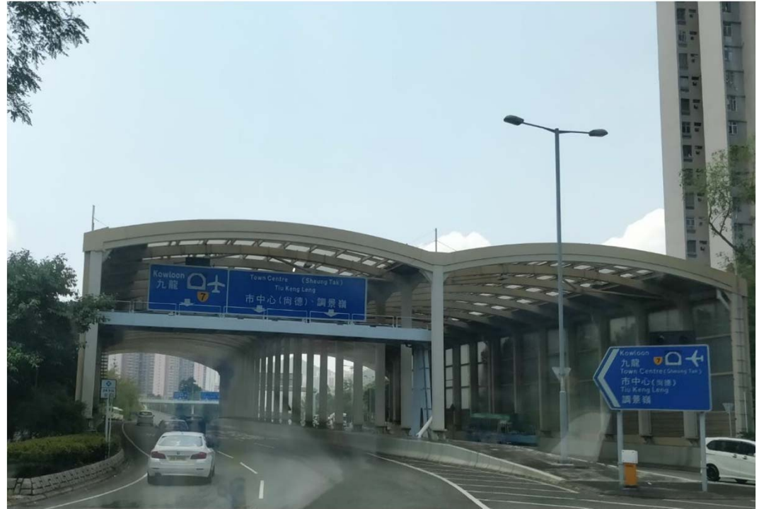
Existing Directional Sign 現時的路線指示標誌:
