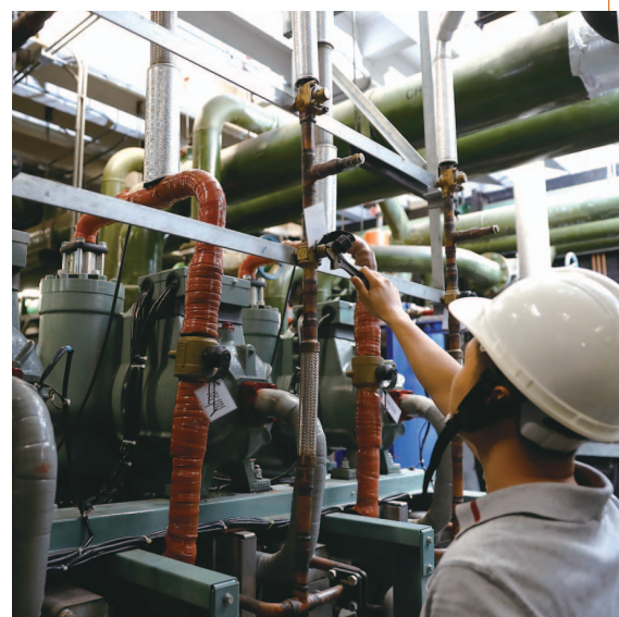
我們的同事為遠距冷凝系統進行檢查，以確保系統運作正常，為大會堂提供後備空調。
