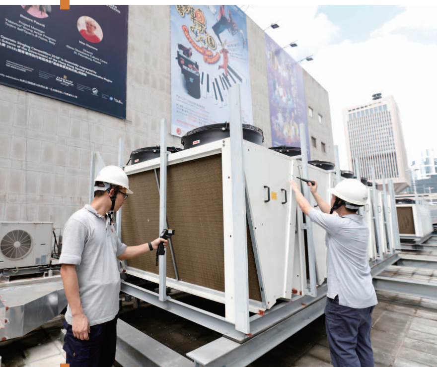
我們的同事為遠距冷凝系統進行檢查，以確保系統運作正常，為大會堂提供後備空調。
