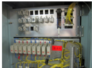
在控制櫃內裝設障礙開關掣
