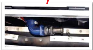
左側噴水裝置
