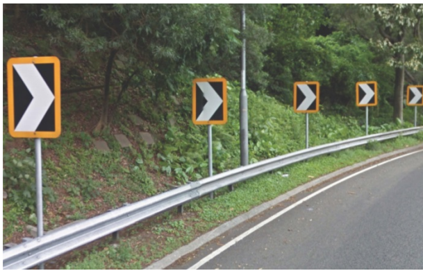
於急彎路段設置警告交通標誌
