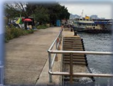
Existing Landing Steps 現有登岸梯級
