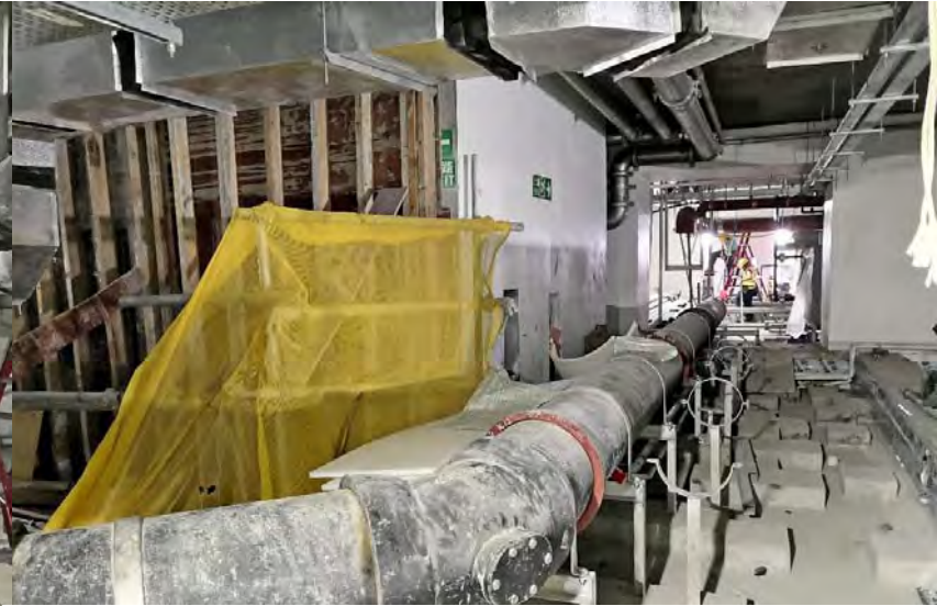
2 nd Fix for Major Pipework 第二組主要管道
