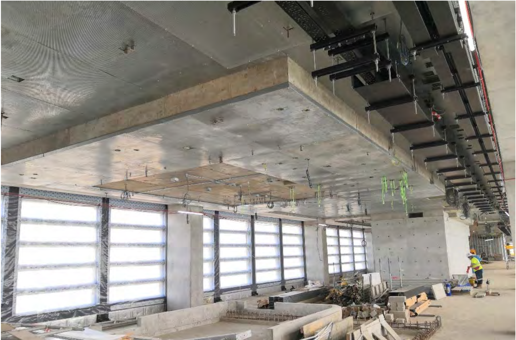
12/F M+ Tower – MEP and Ceiling Installation Works 12樓 M+ 縱向大樓 — 正在進行機電工程及天花安裝工程
