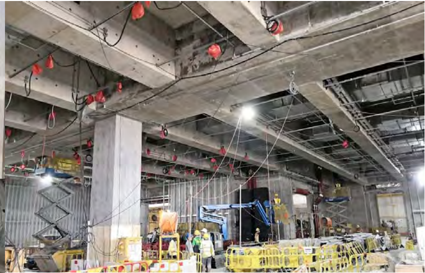
MEP 2 nd Fix - Temporary Exhibition Area 第二組機電工程裝置 - 臨時展覽空間
