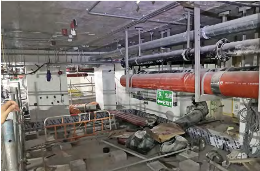
1 st & 2 nd Fix for Major Pipework 第一及第二組主要管道
