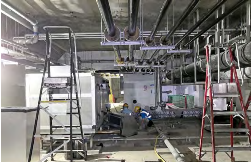
1 st and 2 nd Fix MEP Installation 第一及第二組機電工程裝置
