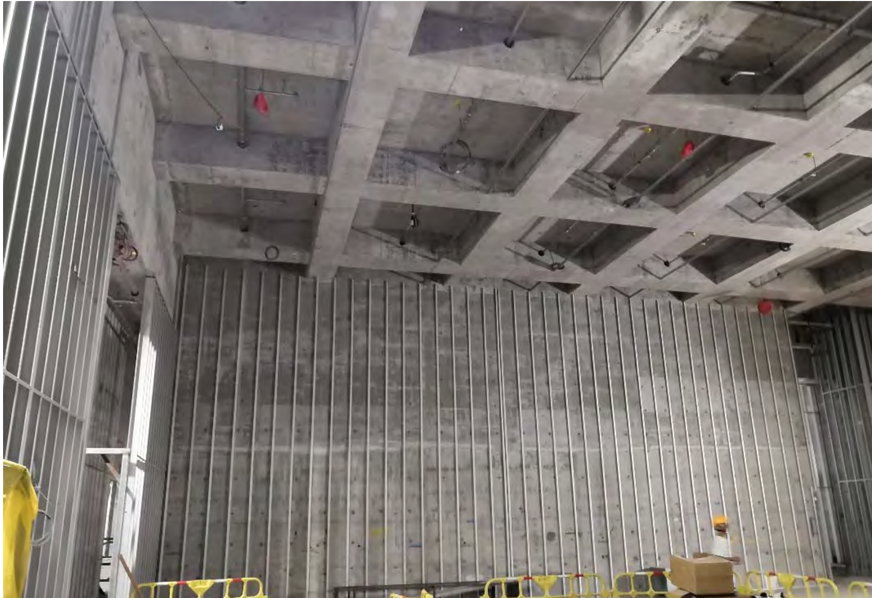
2/F - M+ Podium ABWF Wall Lining - Tall Gallery 2樓 M+ 縱向大樓建築及樓宇裝修工程牆身內部 - 高樓底展覽空間
