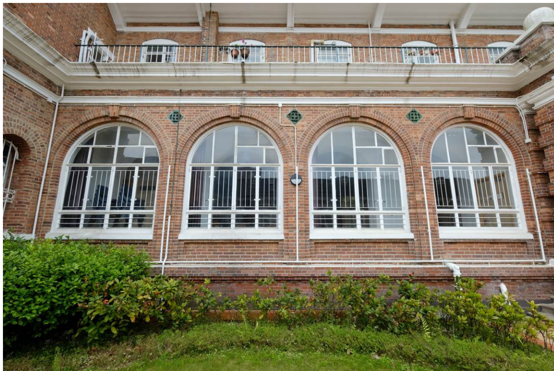
地下被圍封的遊廊（北立面）
