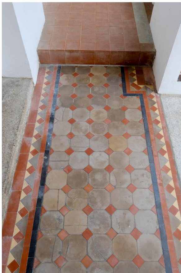
北立面遊廊的舊地磚
