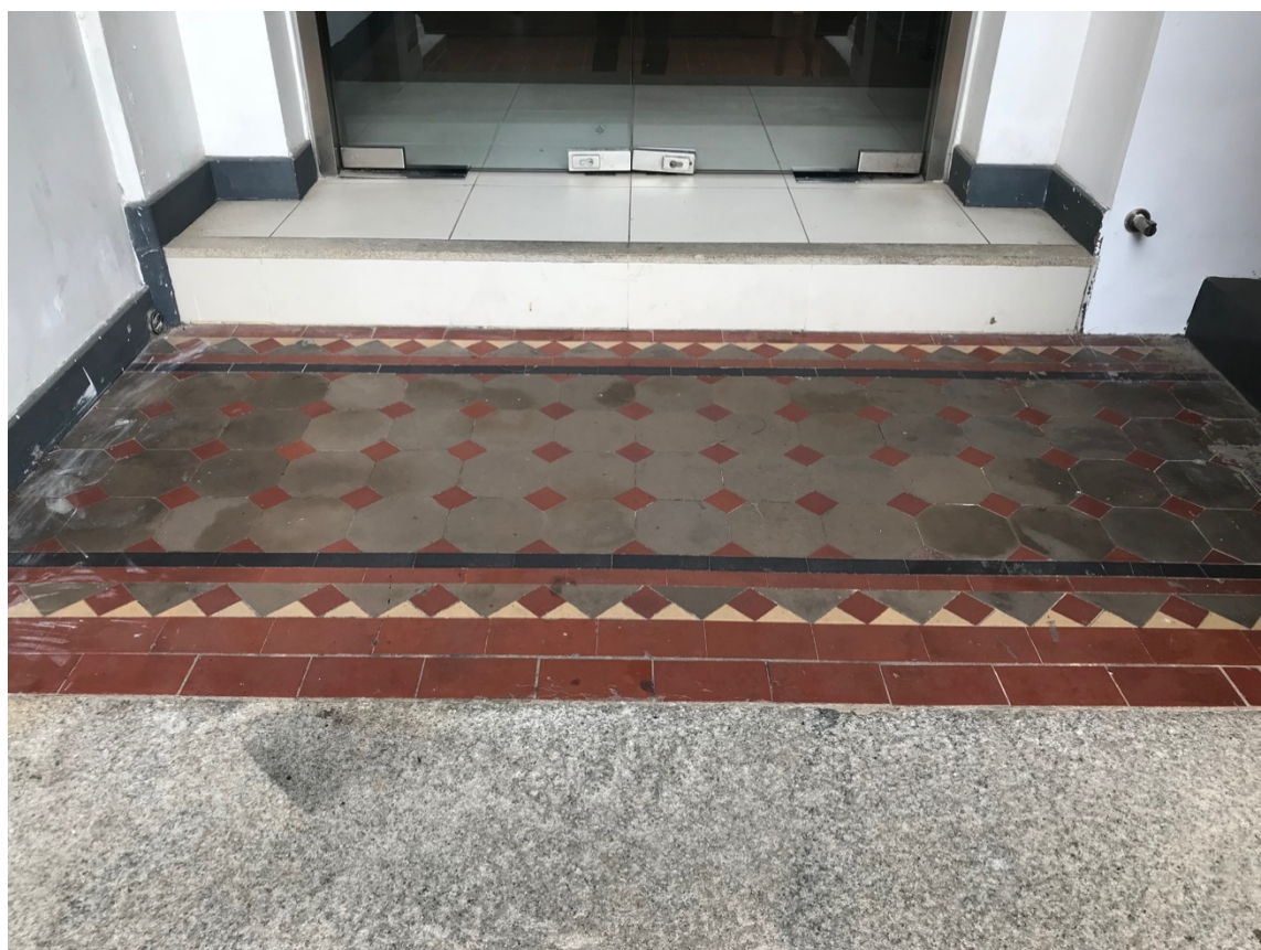
北立面遊廊的舊地磚
