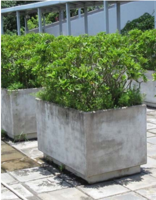
花槽 (建築物屋頂) Planter(on roof)
