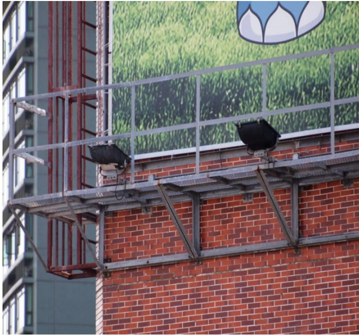
金屬構築物 Metal structure
