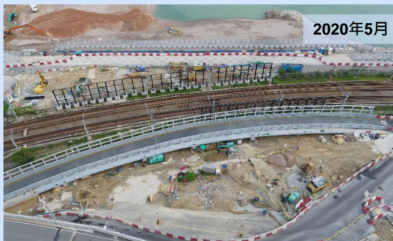
機場快綫下的隧道工程
