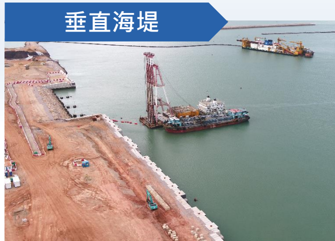
填料鋪設工程
