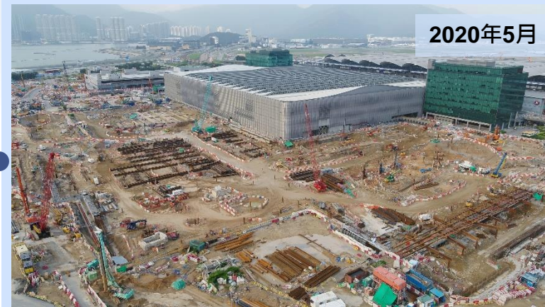
擴建二號客運大樓前期工程
