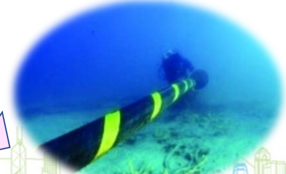
海底通訊光纖電纜
