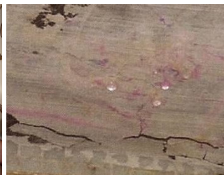
供水喉管 反向壓力測試
