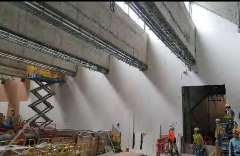
2/F Podium Skylight Gallery 橫向基座平台 2 樓 Skylight 展廳
