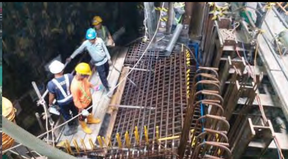
F10a 及 F10b 基礎工程結構 RC works for footings F10a & F10b
