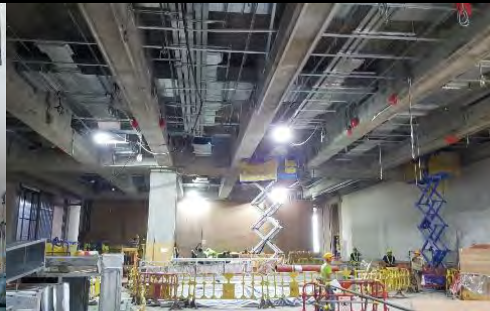
2/F Podium Open Gallery 橫向基座平台 2 樓 Open 展廳
