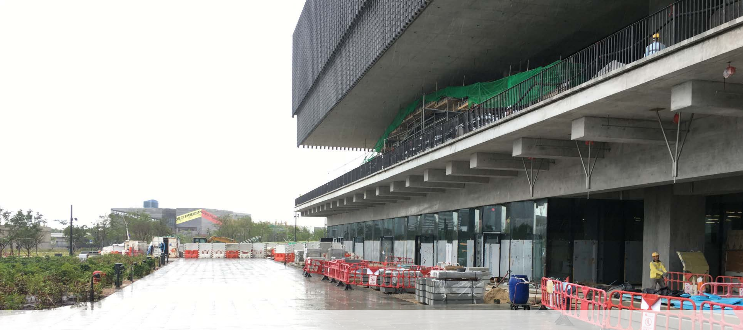
M+ Podium – Basement (B1) Emergency Vehicular Assess & South Entrance M+ 橫向基座大樓 – 地庫一層緊急車輛通道與南面入口
