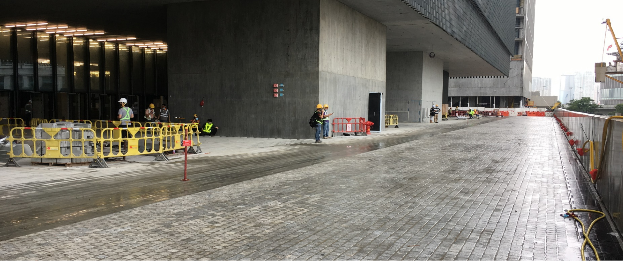
M+ Podium – Ground Floor East Emergency Vehicular Access M+ 橫向基座大樓 – 地下東面緊急車輛通道
