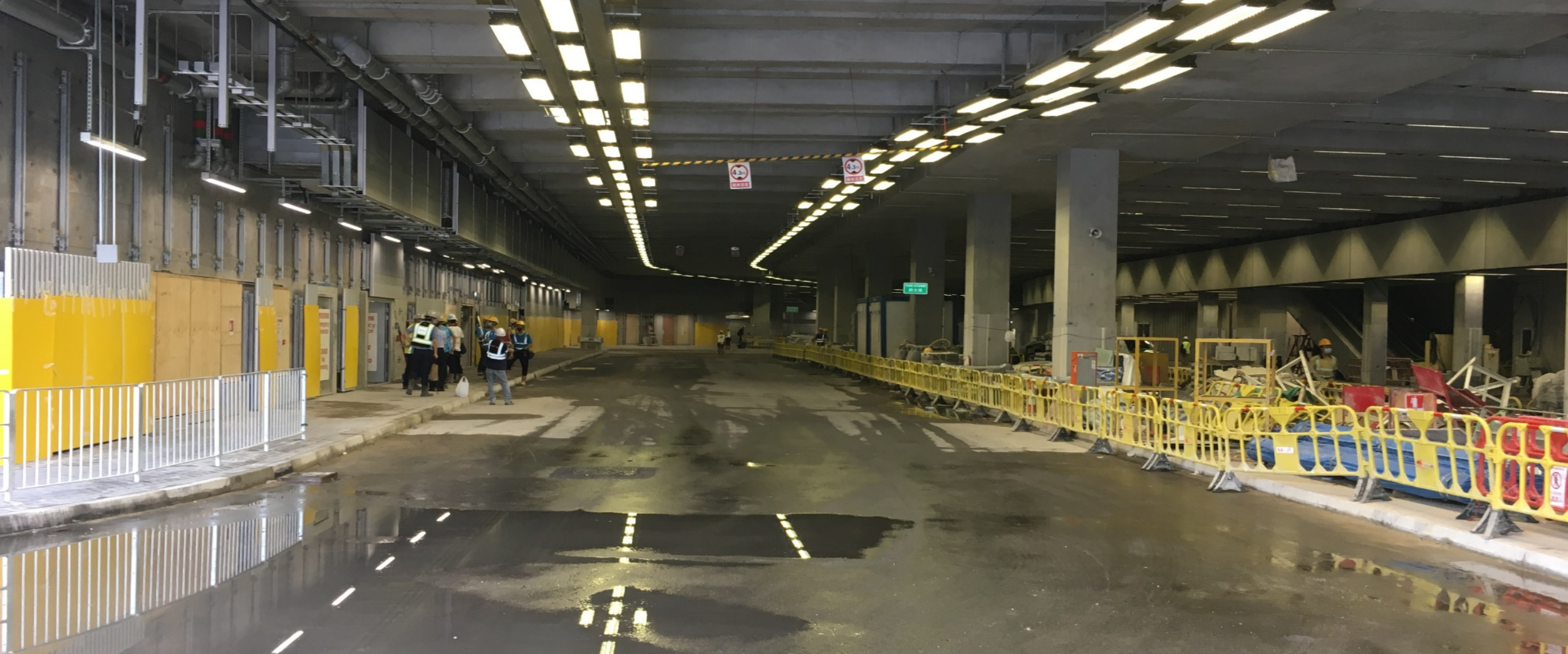
M+ Podium – Basement (B1) Carriageway M+ 橫向基座大樓 – 地庫一層行車道
