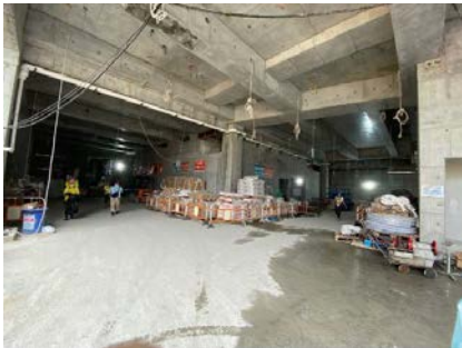
上落卸貨區 Loading/unloading Bay
