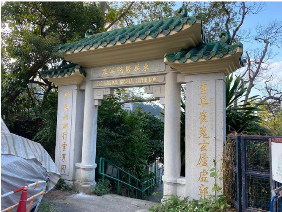
義莊位於域多利道附近的 中式牌樓 牌樓由花崗石建造及有水刷石飾面，綠色琉璃瓦頂飾有正吻及模塑簷楣。
