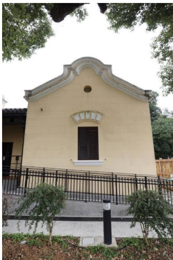
主樓的荷蘭式山牆設有小圓窗和窗戶上方的五個拱楔。
