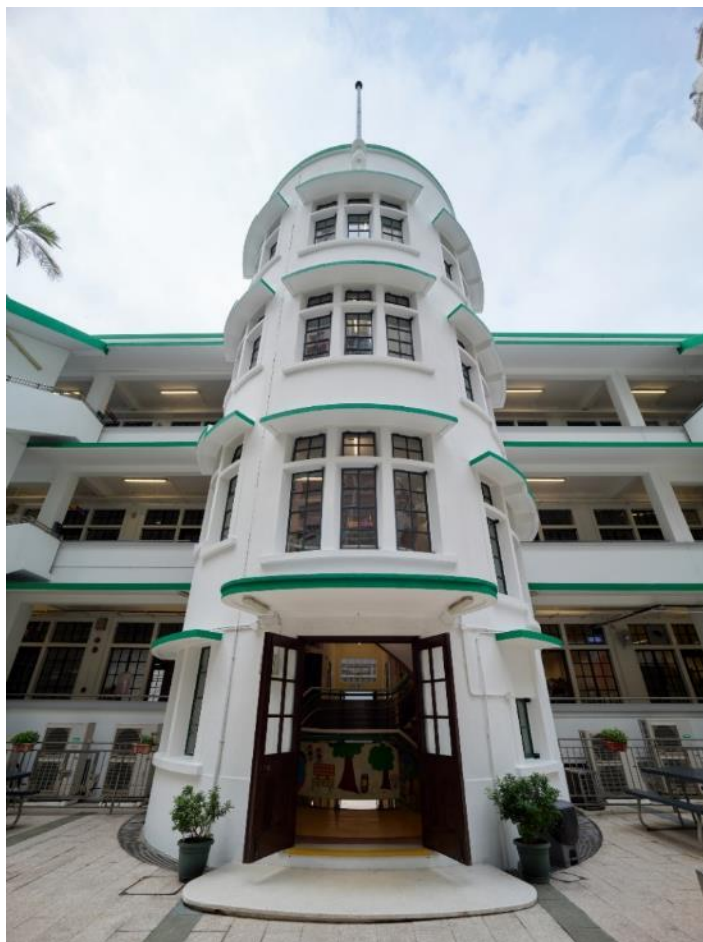
中央樓梯連弧形外牆，旗桿豎立於天台中央位置。
