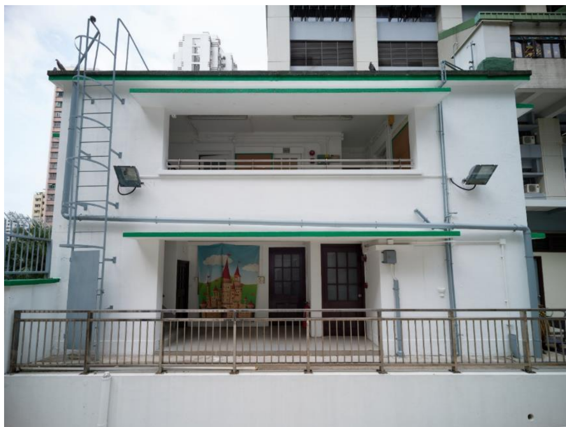
前工人宿舍樓高兩層，位於東邊街入口閘門附近。
