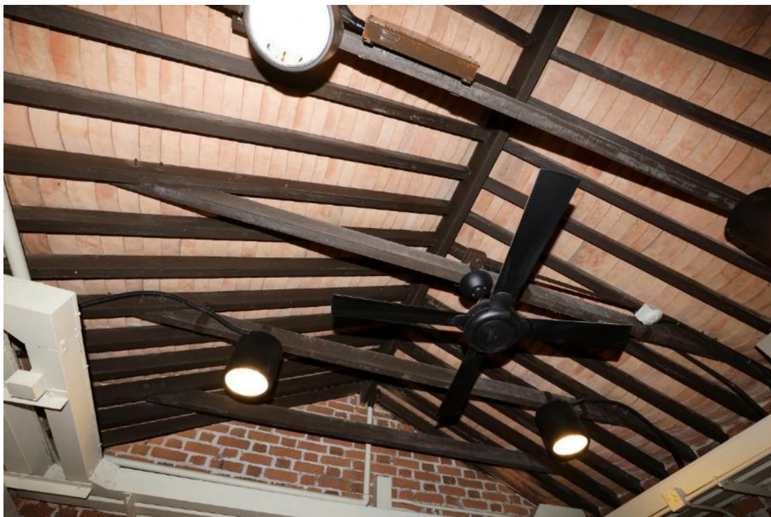
職員宿舍的中式金字瓦頂，以木椽條及桁樑支撐。
