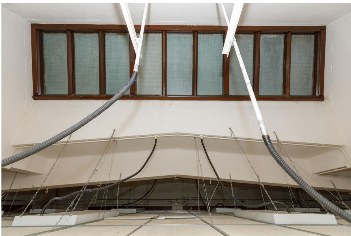
二樓美術室的假天花上方仍可看到金字橫樑及已圍封天窗的底部， 天窗由木框及玻璃組成。
