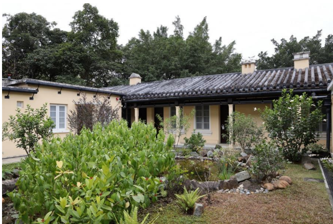
主樓的中式金字屋頂以板瓦及筒瓦鋪砌，屋頂仍見多個煙囪。
