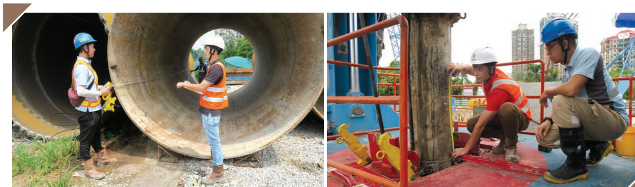
測量地基工程項目的鋼套管長度(左)和監督在反循環鑽孔機平台上的大口徑鑽孔樁工程，以確保建築質素
