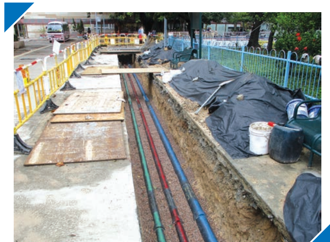
順安邨更換地下供水管道
