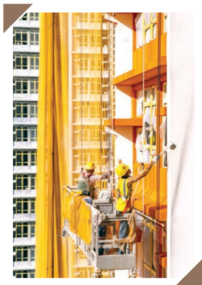
工人粉飾公屋大廈外牆
