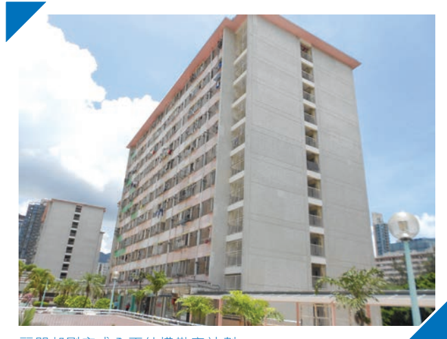
麗閣邨剛完成全面結構勘察計劃
