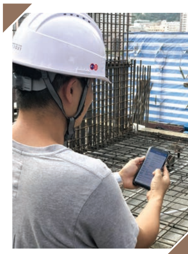
(左圖)利用「發展及建築工地流動系統」的應用程式， 精簡建築工地的安全管理工作 (右圖)為機械人設定試水要求
