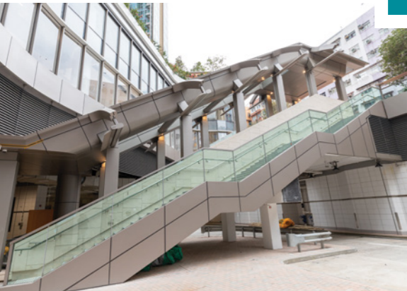
於裕民坊公共運輸交匯處安裝的無扇葉通風裝置，有助空氣流通及減少耗電。
