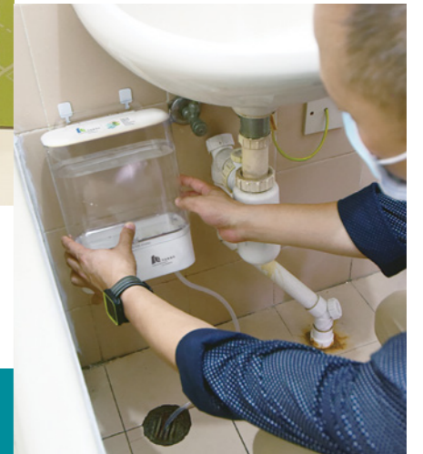
「創意工程及建築設計比賽」金獎設計「U型隔氣彎管自動補水器」的得獎團隊（左圖）。該設計經改良及測試後將裝設於市建局的安置大廈及部分已收購的物業（下圖）。
