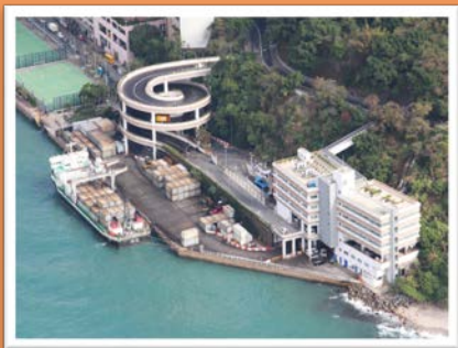
港島西廢物轉運站
