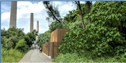
大灣肚污水泵房
