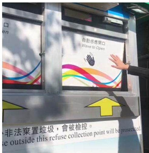
當接近時投入口的門自動打開
