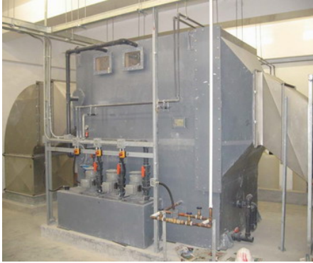
用作過濾空氣的水劑氣滌系統
