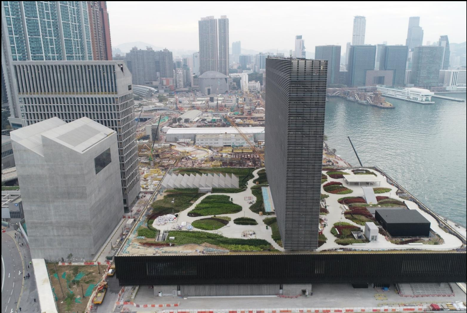
M+ Tower – Façade (West) M+ 縱向大樓幕牆（西面）
