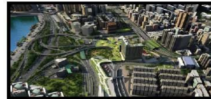
Central Kowloon Route 中九龍幹線
