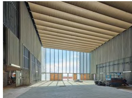
二樓中庭 2/F Atrium
