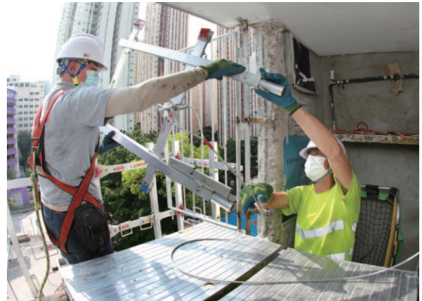
本局研究及優化快速安裝工作平台的安全設計，並於實際環境下測試其實用性。
