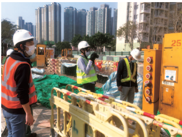
疫情下，職安局繼續為房委會的新建工程地盤進行突擊安全巡查計劃，以提高承建商的安全意識，進一步改善工地的安全表現。
