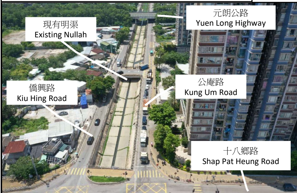
現有狀況 EXISTING CONDITION
