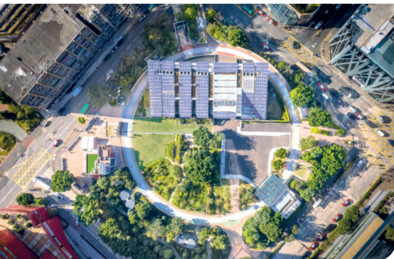
建造業零碳天地持續更新設施
