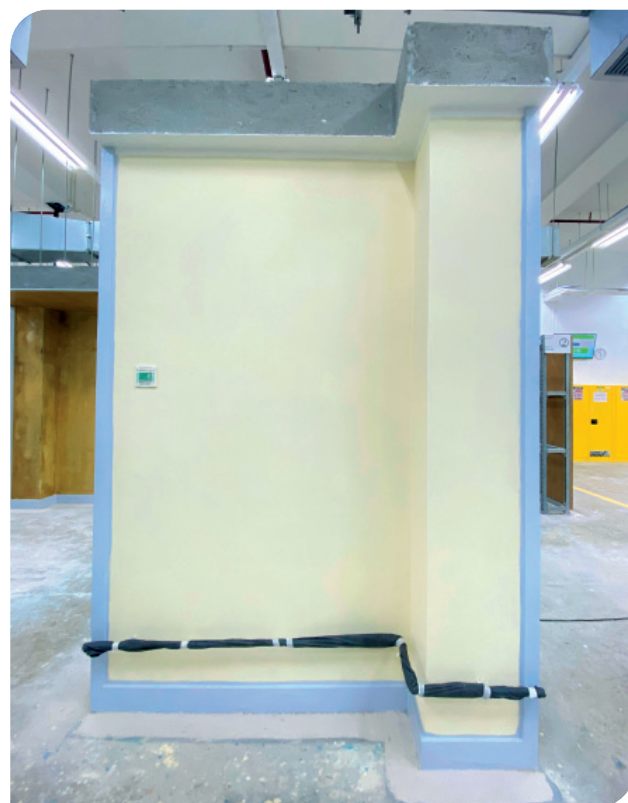
油漆科於實務試試題中加入燈掣及喉管
