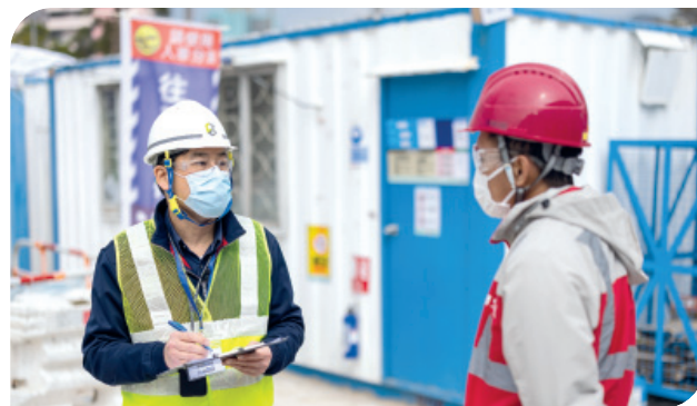
巡查及執法隊巡查建造工地
