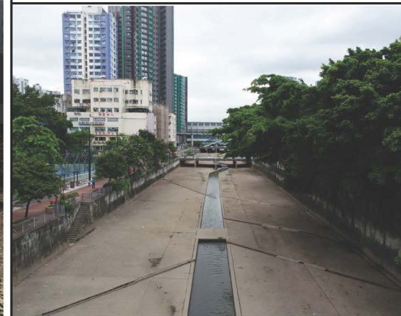
現有元朗明渠的照片 PHOTO OF EXISTING YUEN LONG NULLAH
