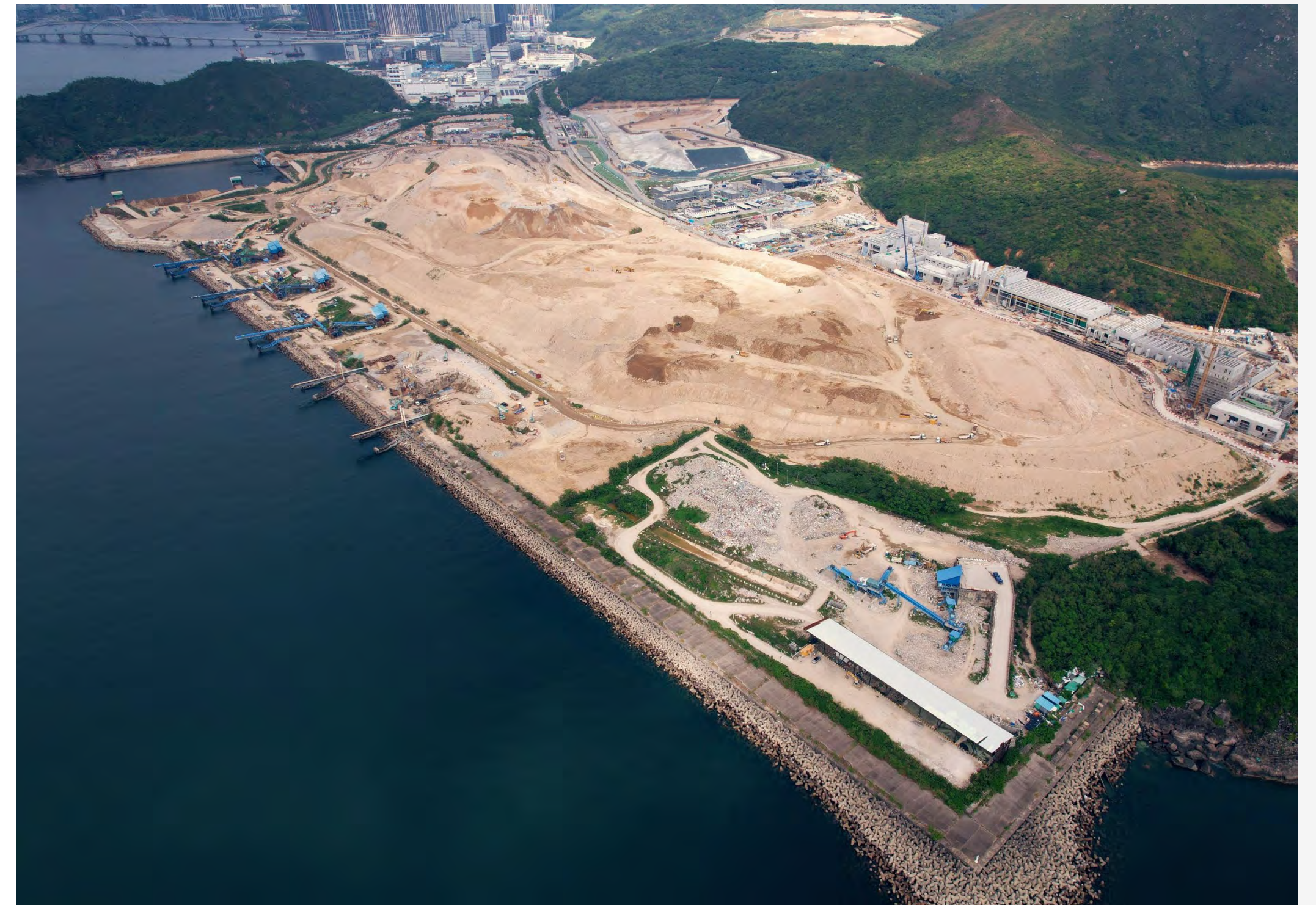
將軍澳第137區臨時填料庫 TKO 137 Temporary Fill Bank
