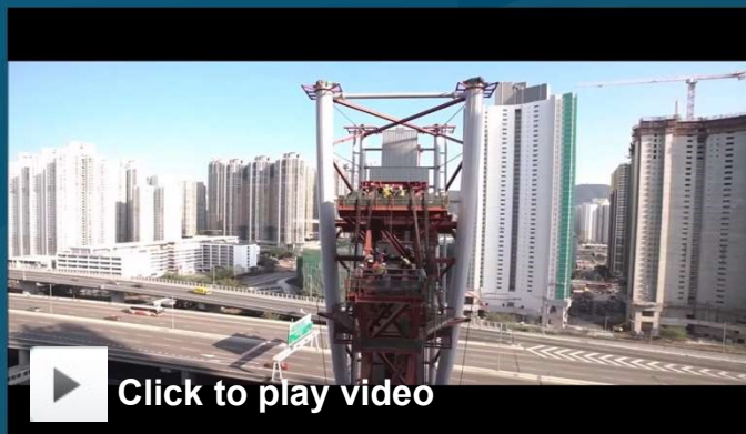
地盤實際操作情況
