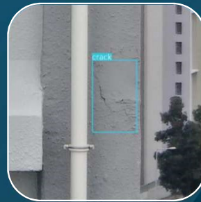
利用小型無人機配合人工智能技術檢測外牆
