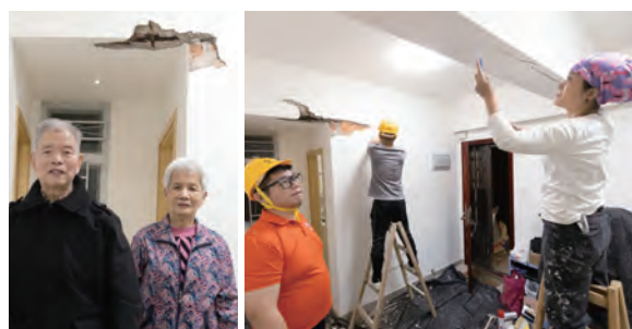
「守望相助」家居維修計劃義工為長者（圖左）的舊樓單位安排檢查和進行小型結構工程，改善他們的居住環境。
