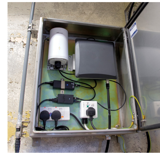
我們為重要基礎設施安裝智慧防洪監察系統，實時偵測場地的水位變化，所得的數據會傳輸到後端系統進行分析。當發現水位出現異常，系統會以電郵和短訊通知相關場地負責人員，以便及早應變。
