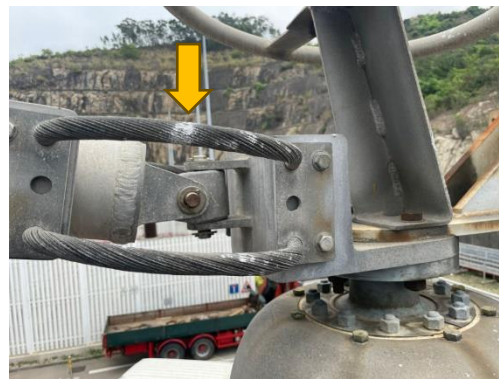
圖 16. C6 機組高壓出口軟連接導體 的受損痕跡
