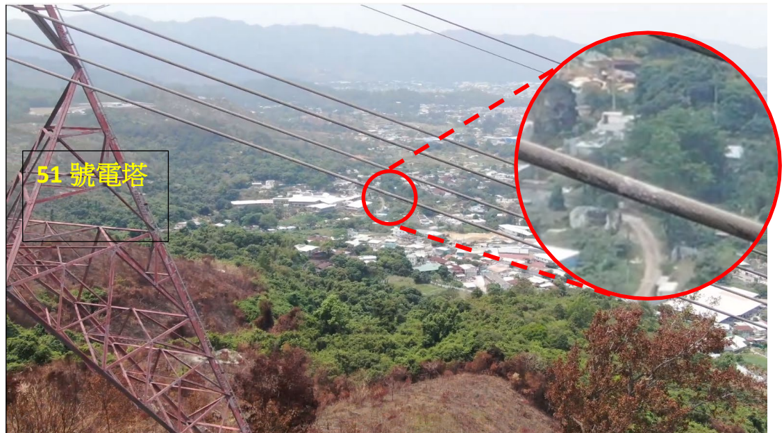
圖 2：51 號電塔附近 L3 相導線線上的閃絡痕跡
