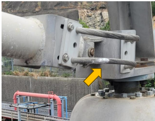
圖 15. C5 機組高壓出口軟連接導體 的受損痕跡
