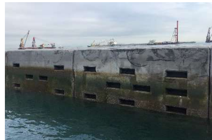
面向石鼓洲的人工島海堤設有生態海岸線
