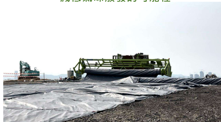
新的機械技術以不透氣膠膜覆蓋堆填作業範圍
