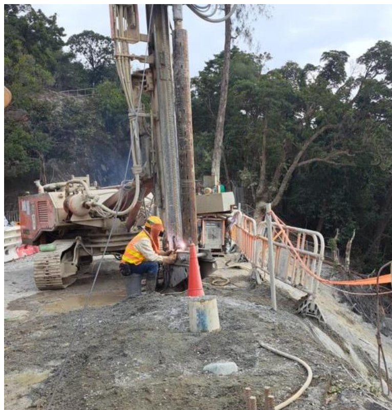
加裝迷你樁鞏固斜坡
