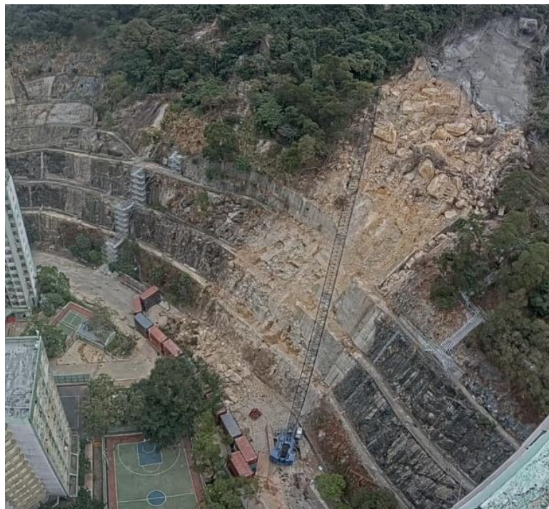
使用大型吊運器械移除坡面上的碎石
