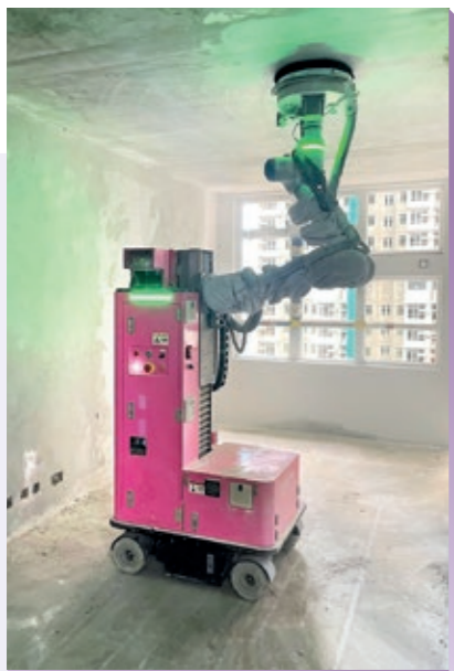
機器人在單位內打磨牆壁和天花 A robot performing wall and ceiling sanding
